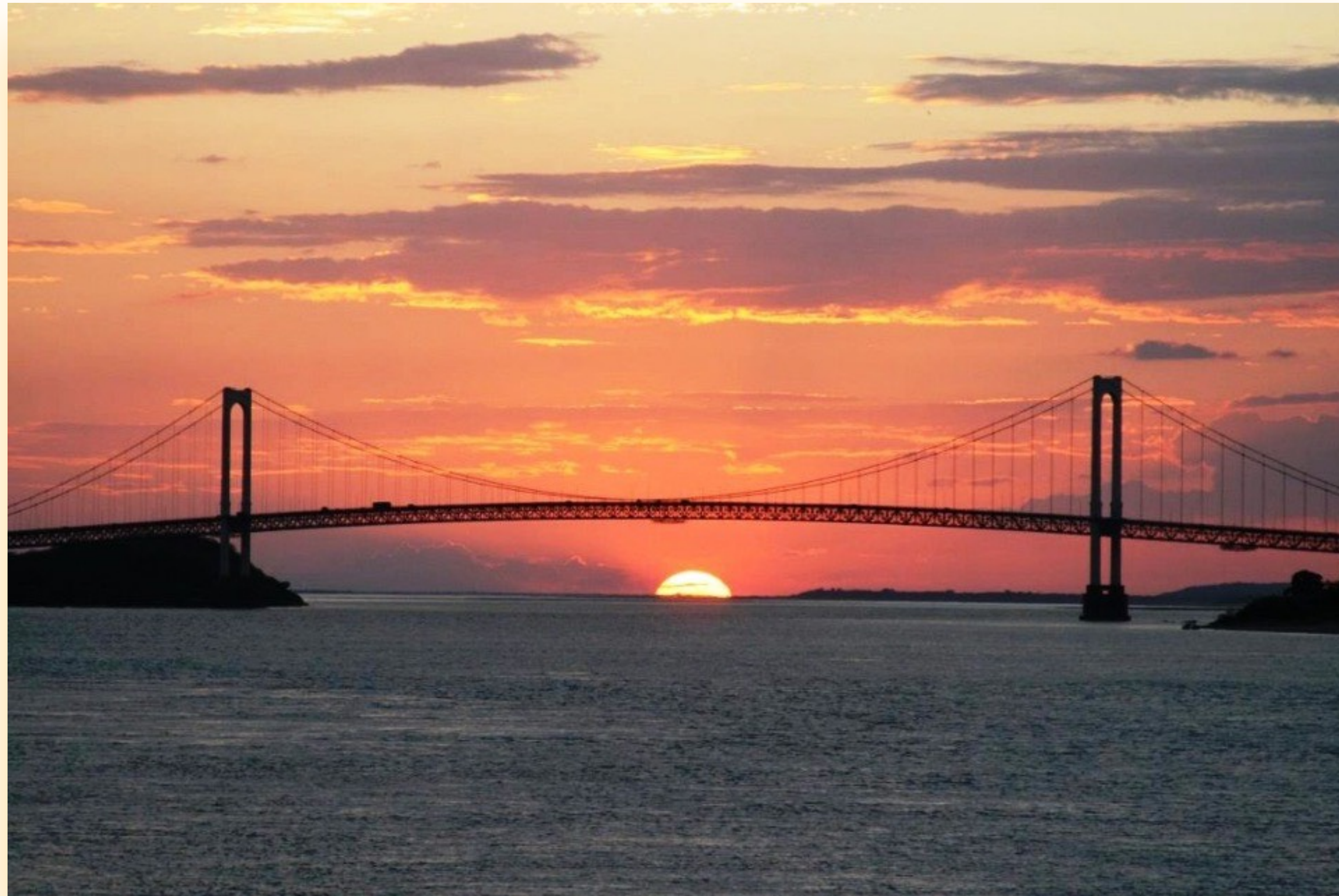
Ciudad Bolívar – Puente de Angostura sobre el río Orinoco (06/01/1967) Primer puente sobre el Orinoco
